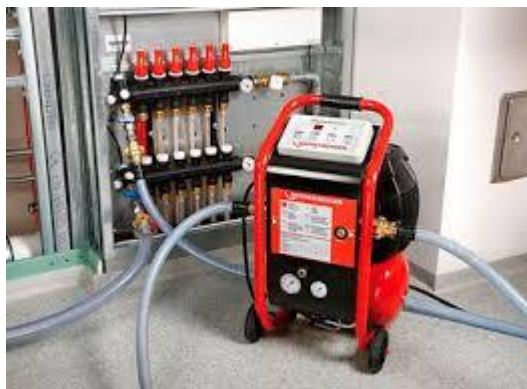
Рисунок 2 Промывка трубопровода внутренних систем отопления
